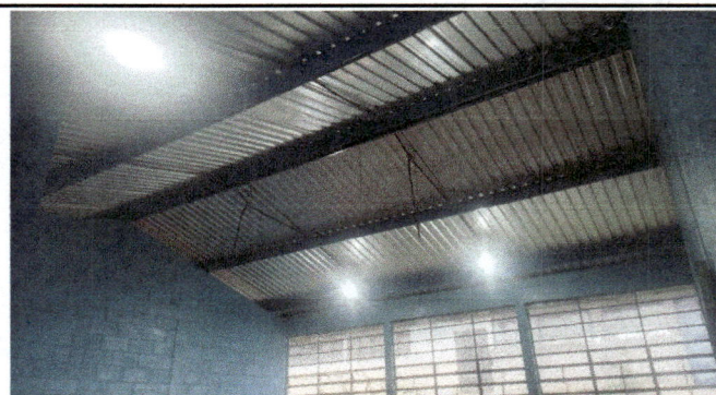
Foto 4: Mantenimiento de Sistema Eléctrico
