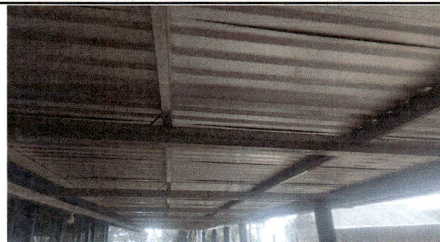
Foto 6: Sustitución de estructura del techo del corredor
