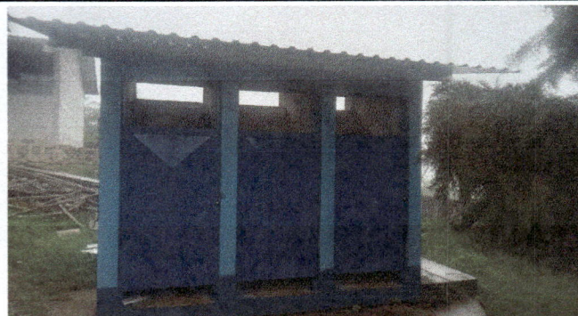
Foto 2: Sustitución de tres puertas de Baño
