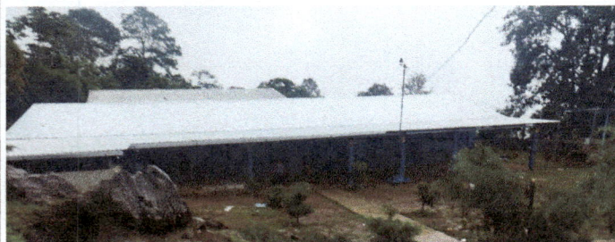
Foto1: Sustitución de cubierto de lámina
